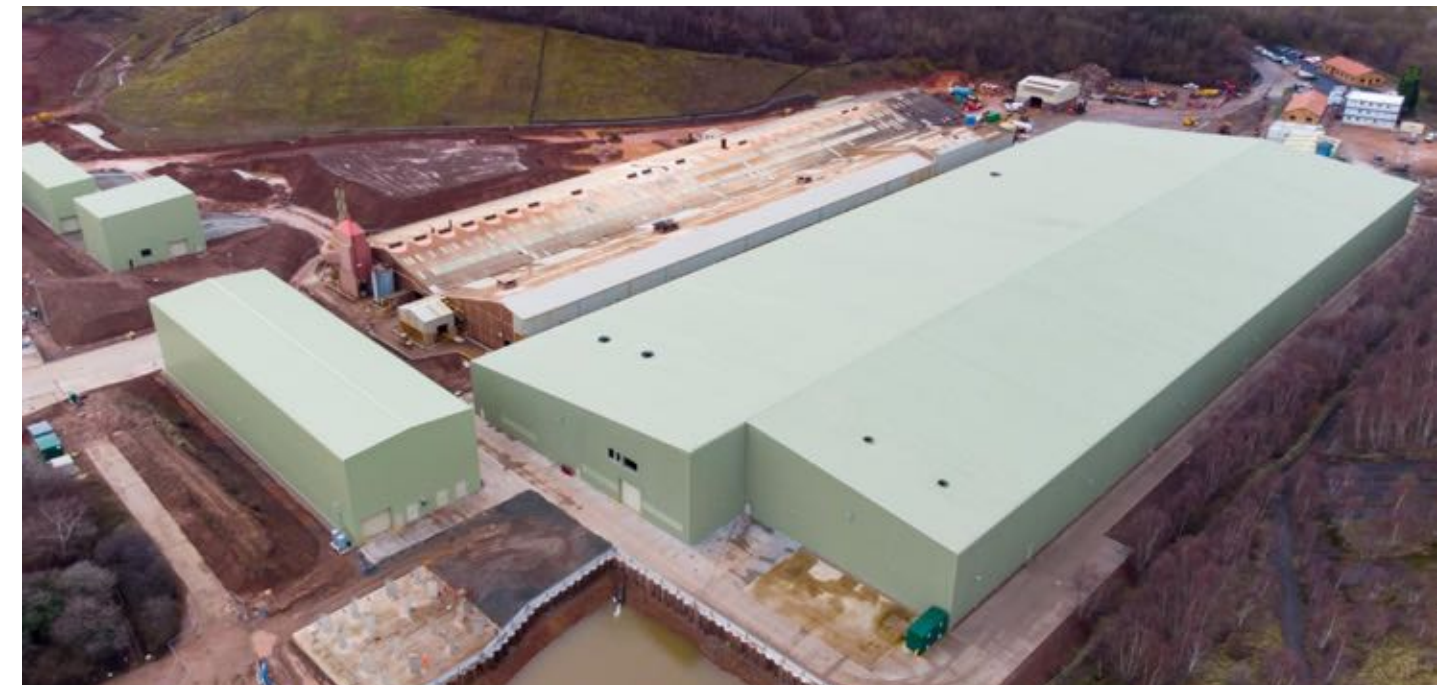
Desford factory under construction ~ Stabilimento di Desford in costruzione
